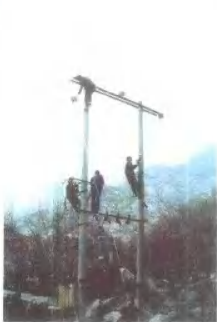
▲1993年至1995年，县电业局投资30多万元，完成了石人山通电工程。1995年，又投资320万元在二郎庙下河村建起一座35千伏变电站。图为1993年2月，在春寒料峭的石人山，县电业局技术人员正在架设10KV双杆线路。
