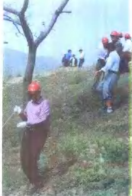
▲秋村乡李子岭村黄柳岭村民组，一直过着靠挖石磨、煤油点灯的生活。县电业局得知此情况，投入10万元，发动职工集资9千元，为该村民组办电。图为1998年4月段长李怀中与该组工人一起在该村民组义务立杆架线的场面。
