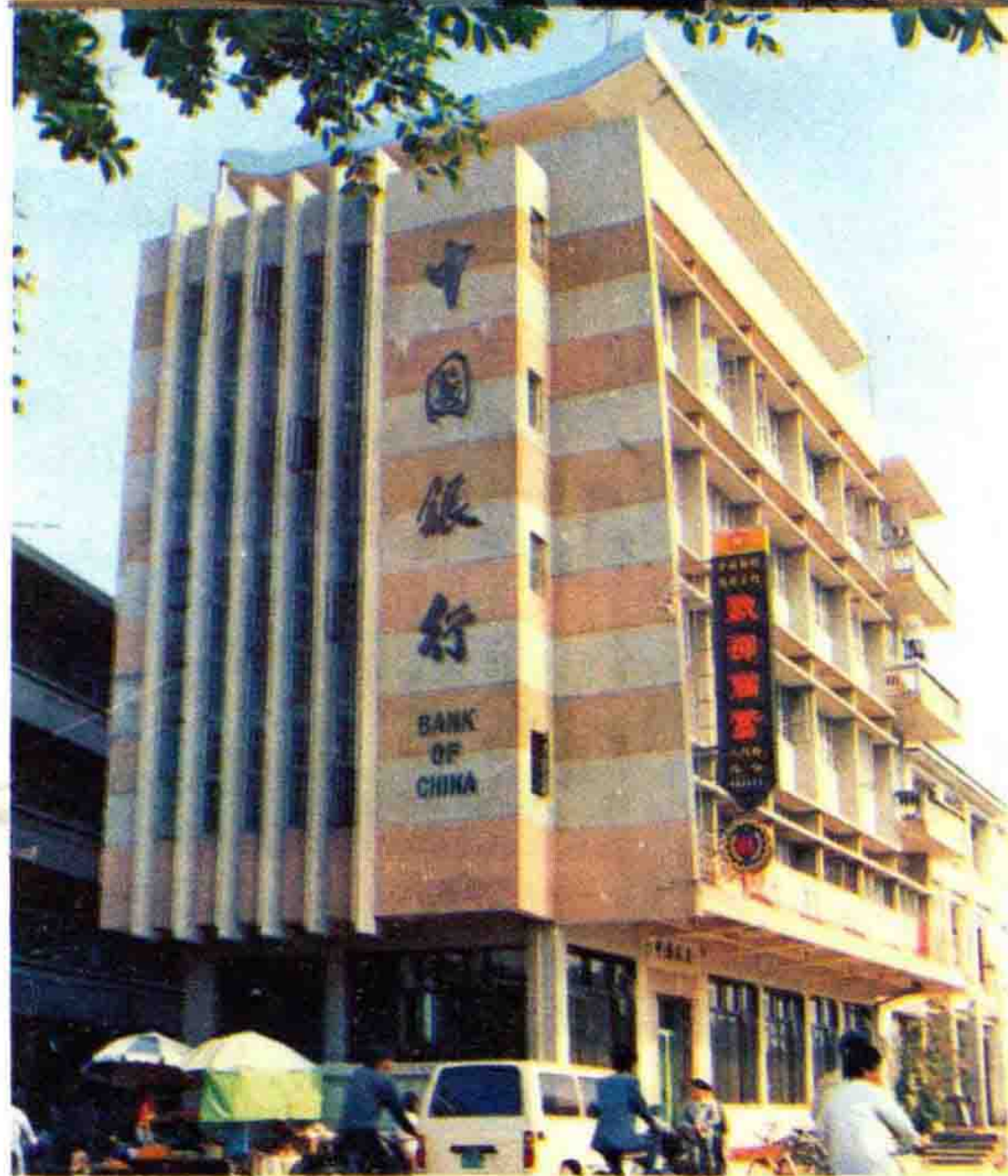
◀ 图为中国银行恩平县支行。行址位于恩城镇沿江路27号。
