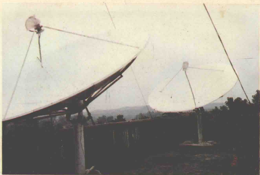
有线电视卫星接收天线
