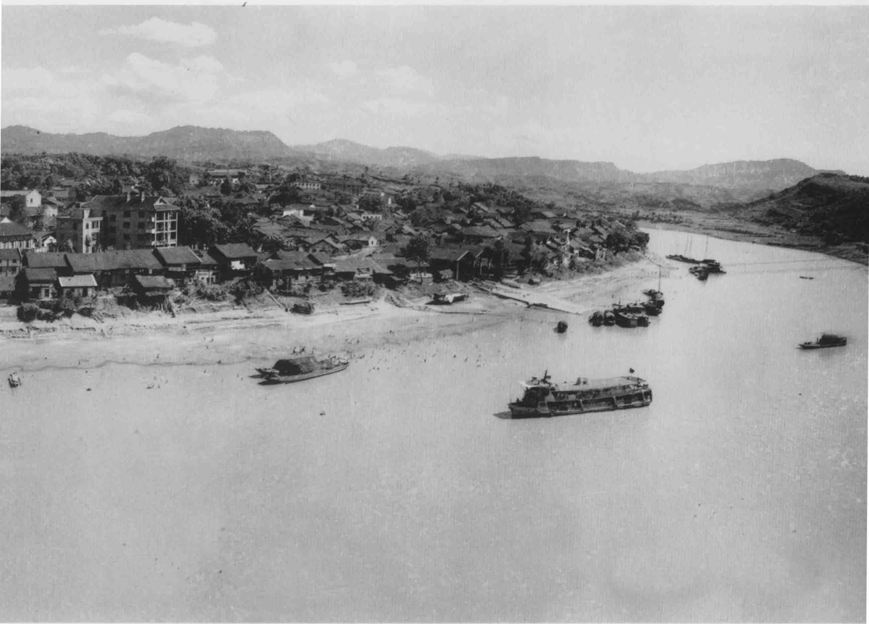
这是从赤水河对岸四川合江县九支镇高处拍摄的赤水老城全景，虽是 20 世纪 70 年代初期所摄，时间不算古老，但举目所见，画面展现的房屋，基本上皆为青瓦平房，整个城市古色古香，保留着民(国)清(朝)旧貌。 (郭首先 摄)
