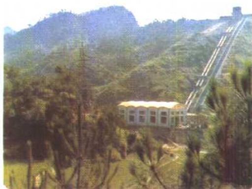
通城县百丈潭 三级电站全貌
