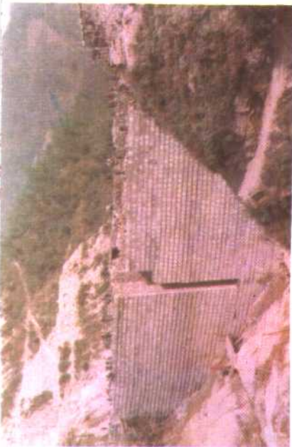
施工中的倒肘湾大坝现场
