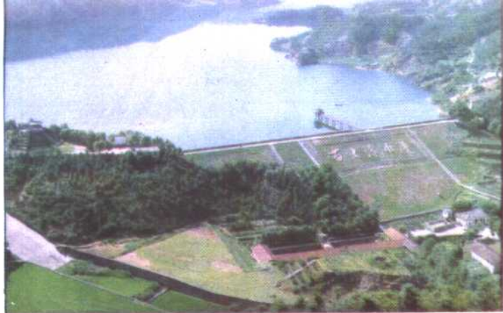
通城县百丈潭 水库全貌
