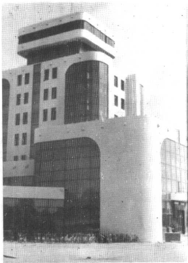
满洲里国际贸易大厦
