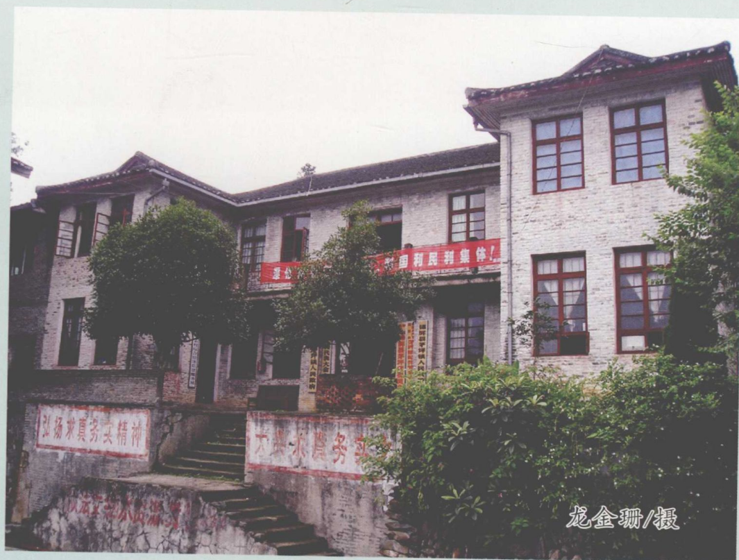
1972年修建的茅坪镇政府办公楼
