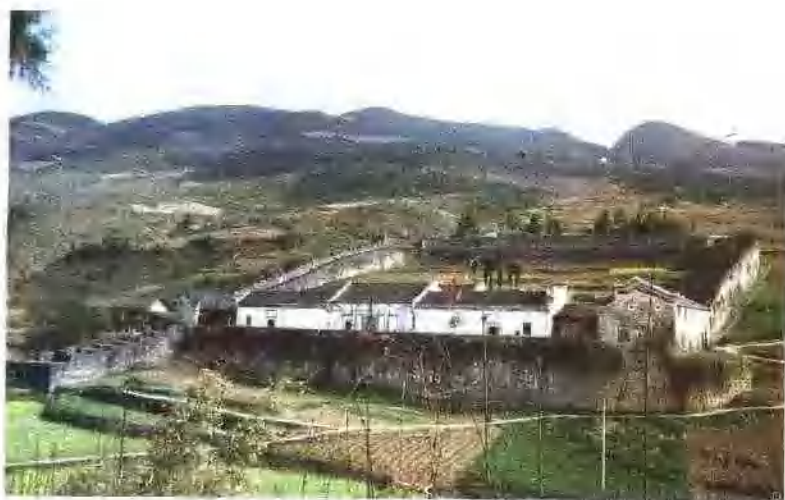
利川大水井古建筑群
