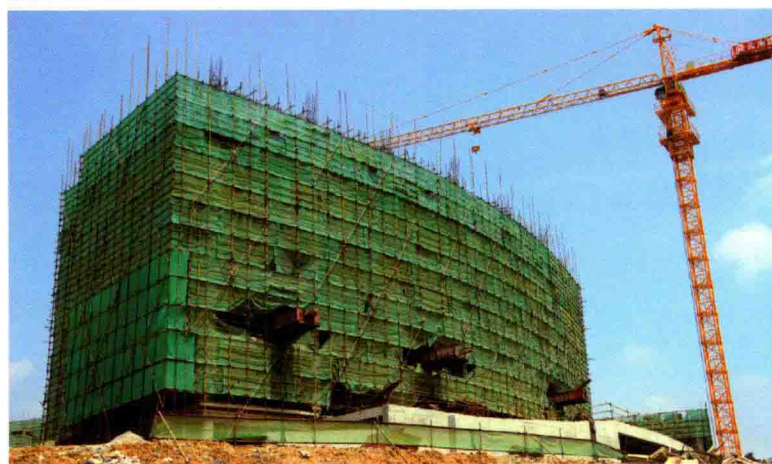
正在建设中的图书馆◎
