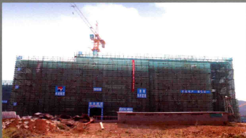
正在建设中的教师教育大楼
