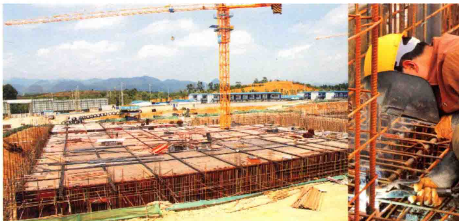
正在建设中的行政办公大楼◎
