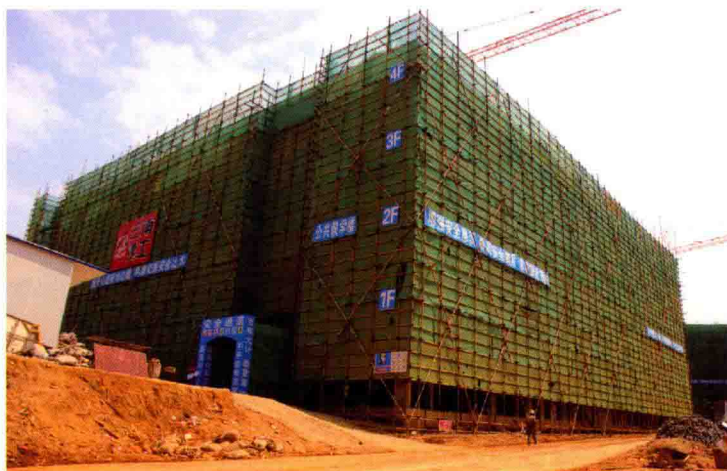
◎ 正在建设中的公共教学大楼
