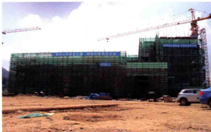
◎正在建设中的学术会议中心
