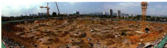
正在建设中的体育馆◎
