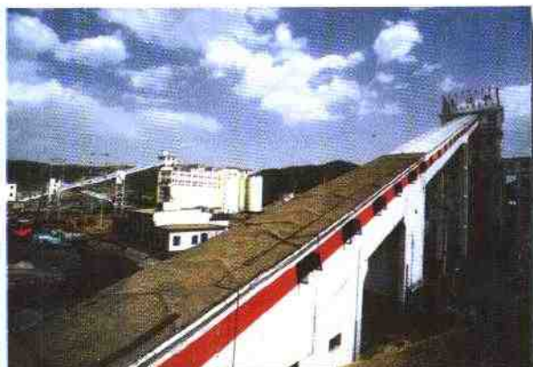
华亭煤矿选煤楼
