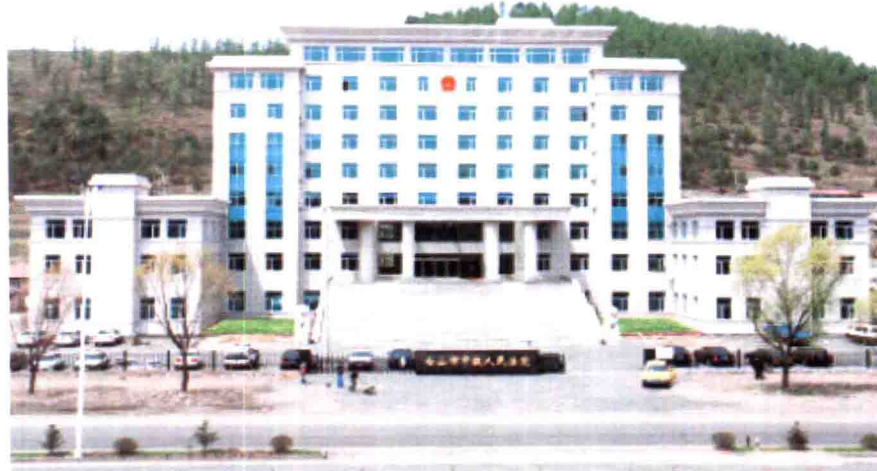
9400多平方米的办公楼于2005年末投入使用
