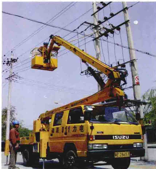
电力抢修及时快捷认真践诺
