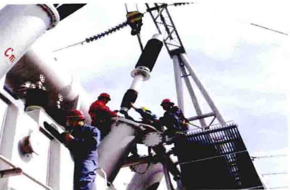
工作人员安装主变道管精心维护着电网设备
