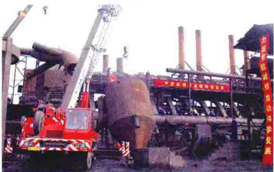
内丘龙海钢铁集团拆除烧结机现场
