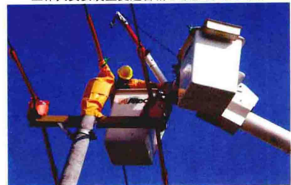
110千伏城市配网带电安装大大减少了停电时间
