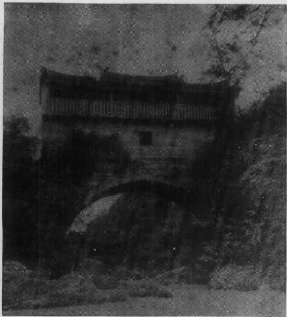
南靖梧宅石门岩的桥亭。
