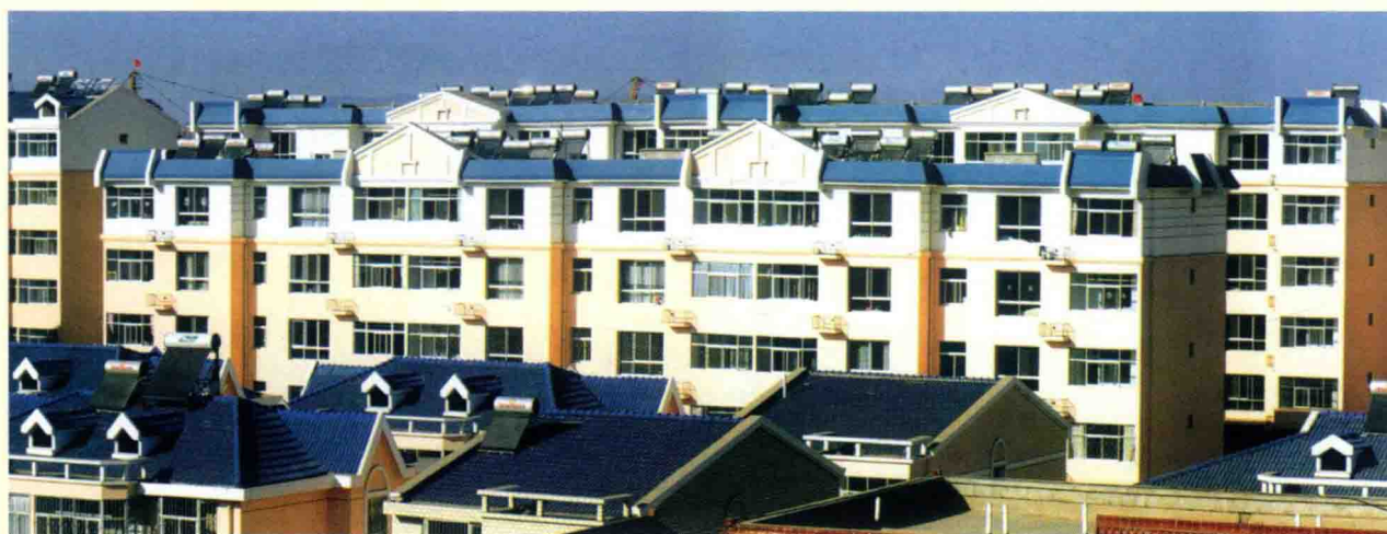
康泰居民住宅小区
