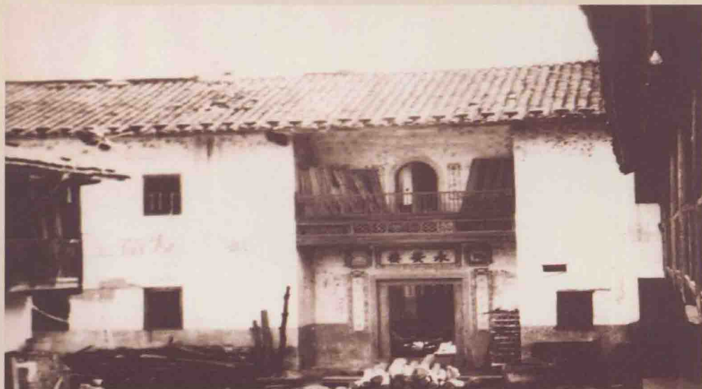
1927年，共产党员张鼎丞住在刘永生家里，以教书作掩护，在丰稔严坑一带发动群众。刘永生原来的房子被反动派烧掉，这是解放后老区扶建时择地重建的刘永生等亲属的房屋。
