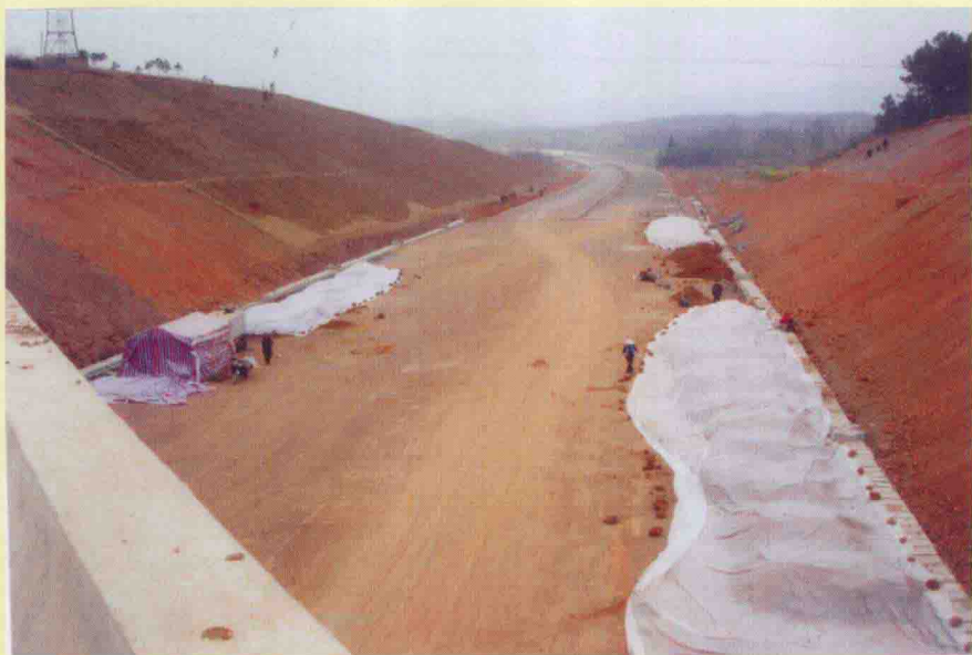
随岳高速公路建设现场
