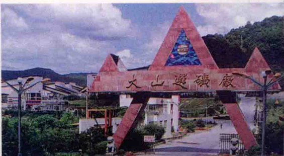
△建行德兴铜矿专业支行支持建设的 德兴铜矿大山选矿厂
