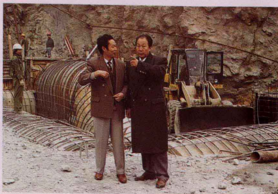
昭通行署秘书长陈家朝到 渔洞水库工地视察
