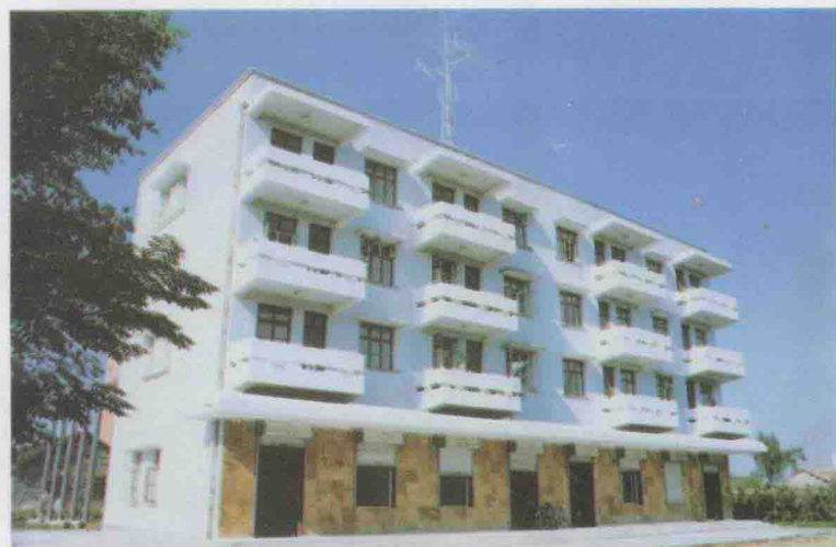
刘巷供电营业楼
