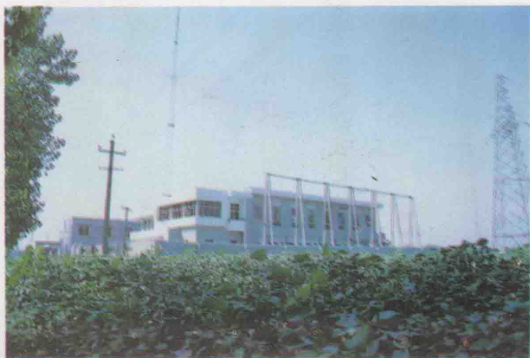
35 千伏董市变电站外景
