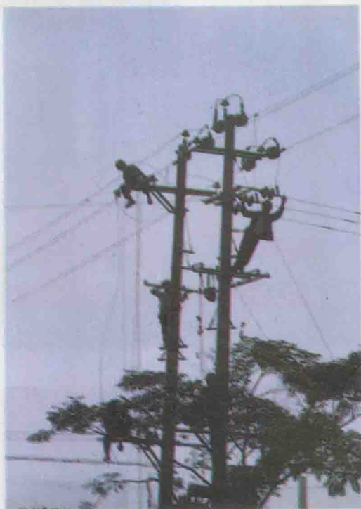
城网改造正在进行中
