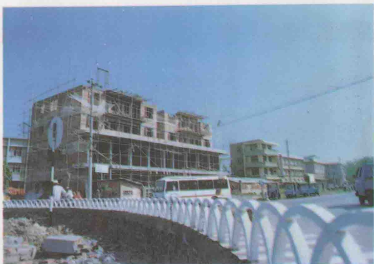
建设中的董市供电营业楼
