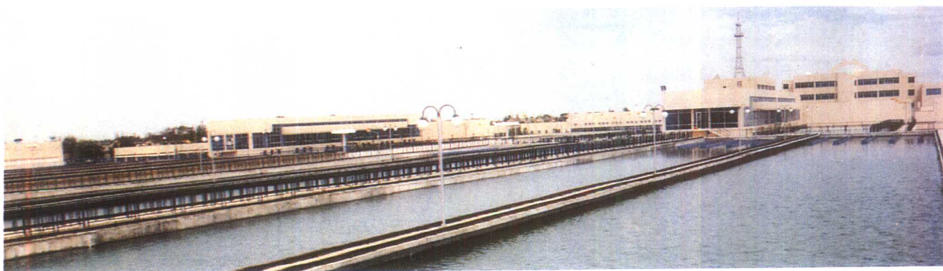
日处理 40 万吨的浦东凌桥水厂
