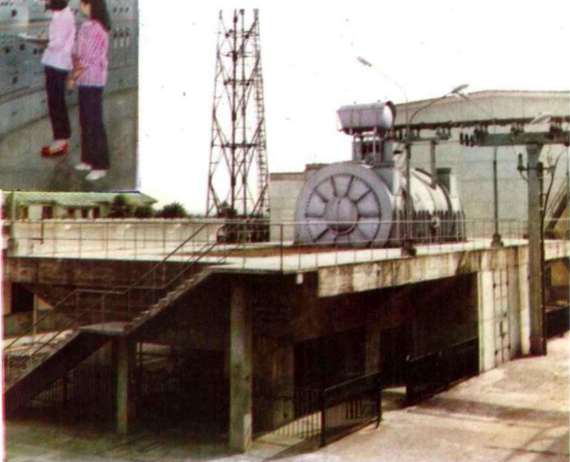
全國第一台全密封、戶外式、氫內冷調相機正在運行
