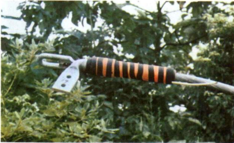
用研製成功的太乳炸藥包在大截面導綫壓接管上準備起爆
