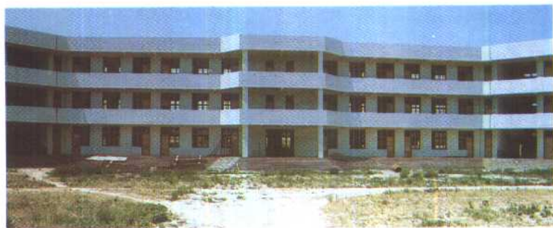
正在修建的马 庄乡古愚中学 教学楼
