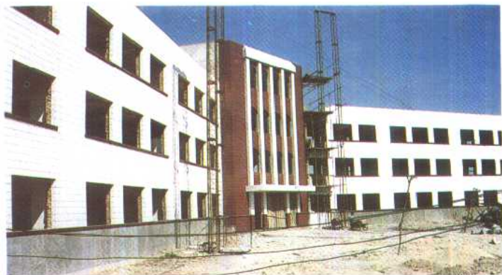
即将竣工的 渭滨乡渭滨 中学教学楼
