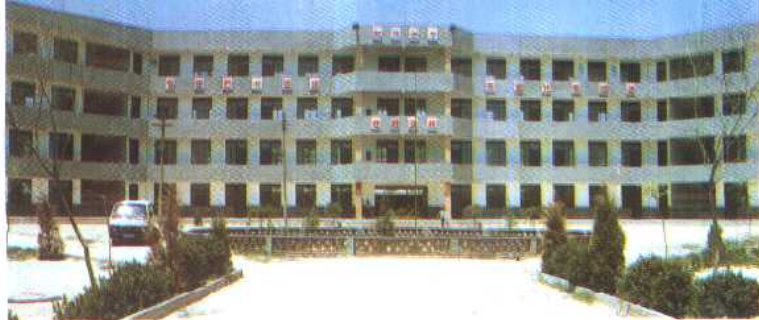
双照乡双照 中学教学楼
