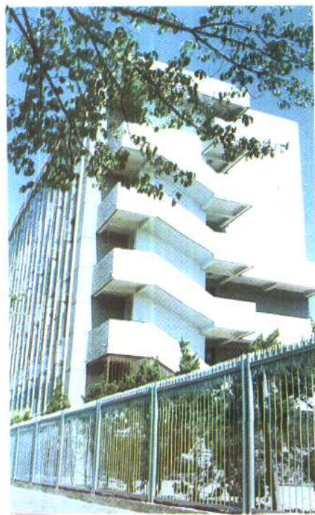
咸阳育才中学学生宿舍楼
