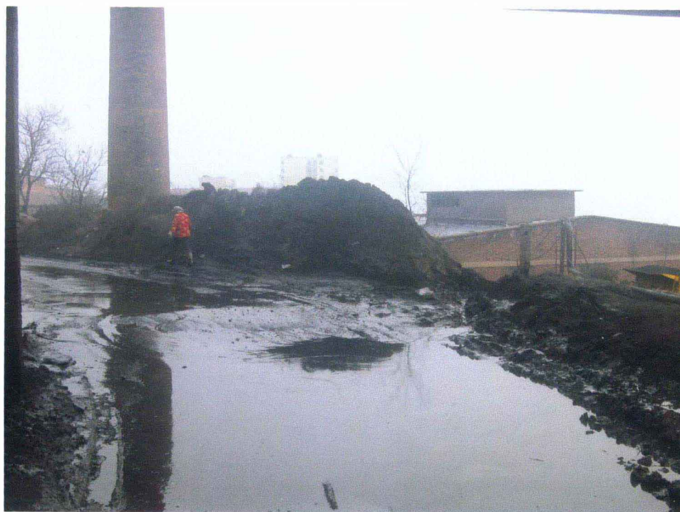
华兴公司修理厂墙外公路积水 拍摄于2012.02.01
