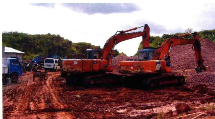
图为梅江区工业基地热火朝天的施工现场
