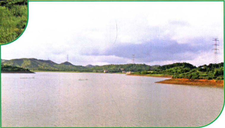
◀ 供水枢纽——流冲渡槽 [摄于 2009 年 8 月 6 日]
