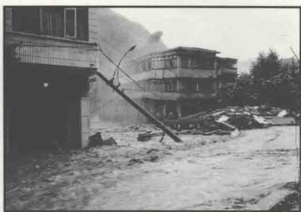
1995年7月1日，镇远县广播电视大楼 毁于一旦 (冯德镇摄)
