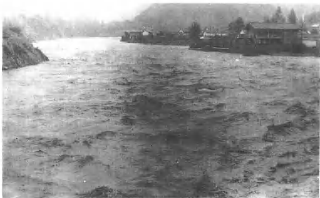
▲ 沘江最大流量达 1150 立方米每秒,沿江两岸损失惨重。(王文松摄)
