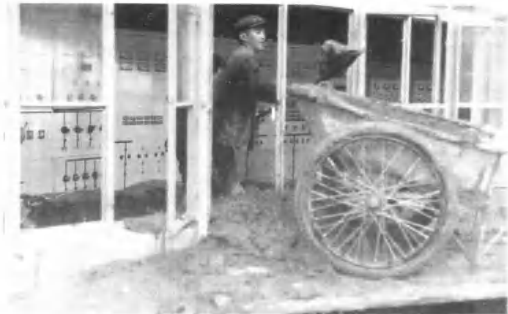
▲新桥电站大坝被冲跨，厂房被淹深度5米，淤积泥沙3米厚。（水电局供稿）
