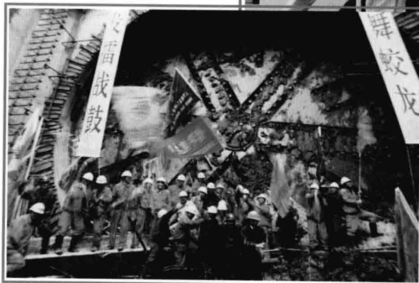
◀ 上海隧道青年突击队员为延安东路隧道盾构出洞欢呼雀跃
