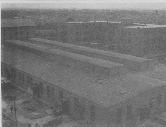
新建的电子工业企业 先锋无线电测量 仪器厂(766厂)
