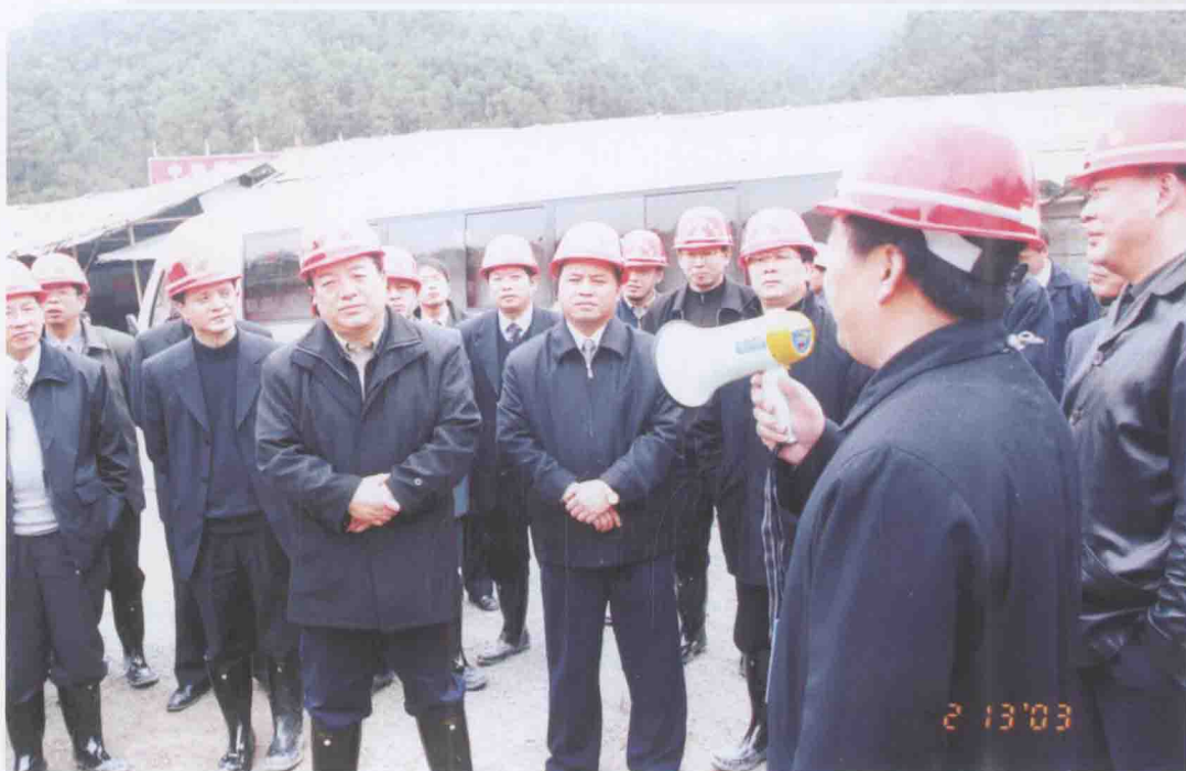
2003年2月13日，省政府副秘书长张志南、市长刘赐贵陪同铁道部副部长蔡庆华检查赣龙铁路工地。
