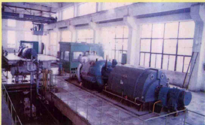
2 \times 6000\text{kw} 的发电机组
