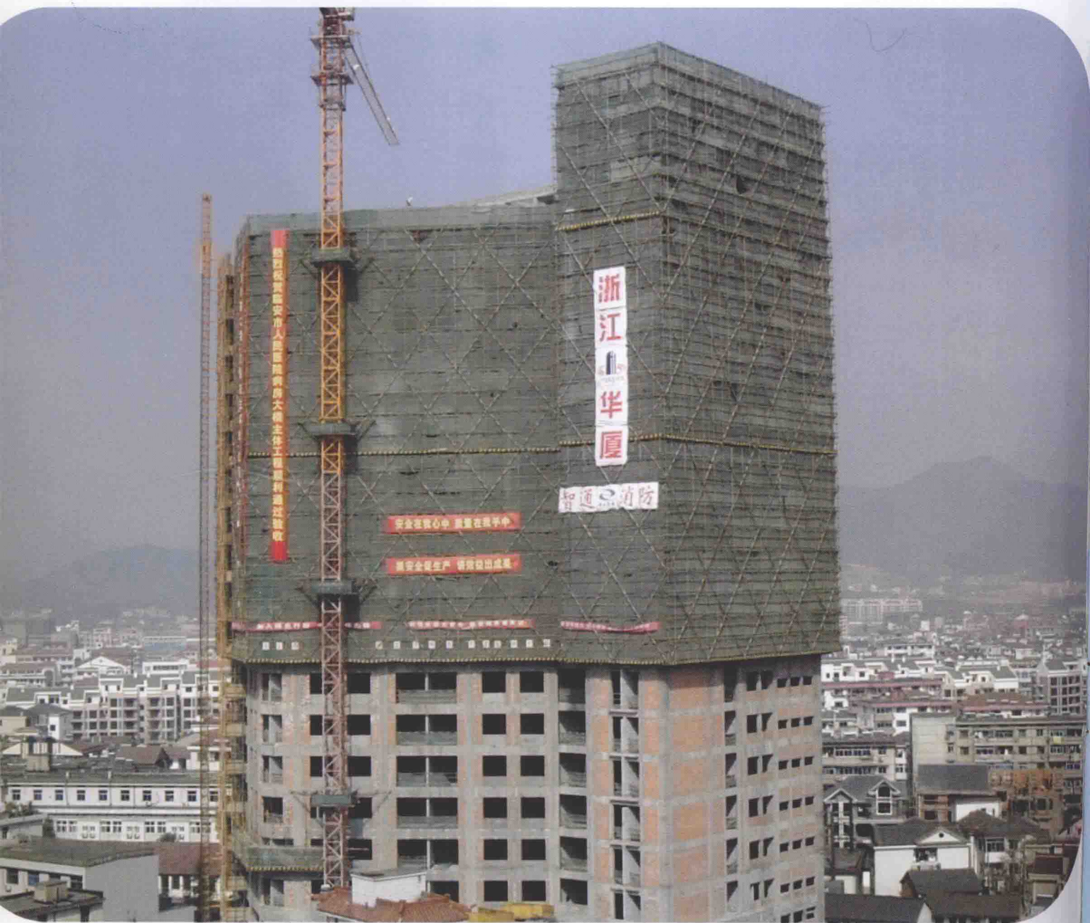
新病房大楼于2004年2月8日破土动工， 主体工程于2004年12月20日顺利结顶。
