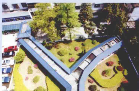
■ 医技大楼 绿色长廊连接门诊大楼和
