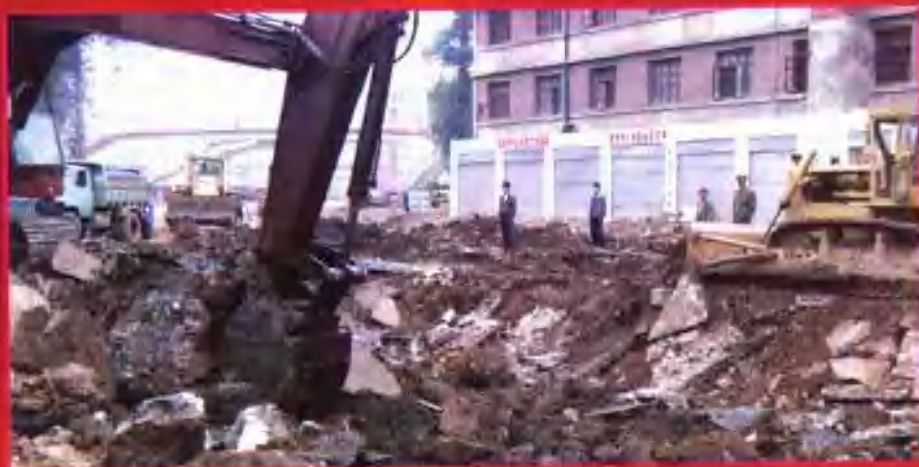
施工中的西昌路
