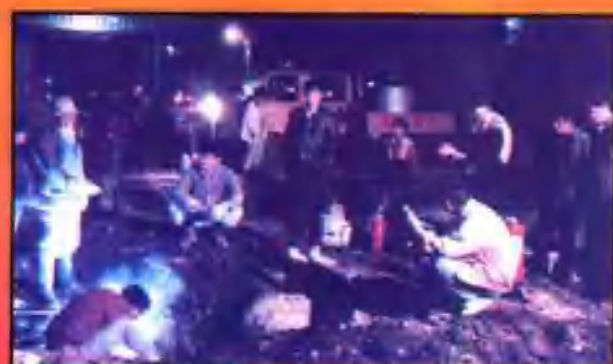
施工现场夜间抢险
