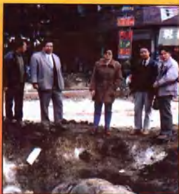
区政府领导亲临施工现场
