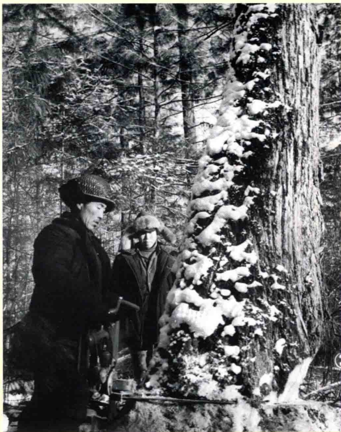
油锯替代手工伐木，大大提高了生产效率。
