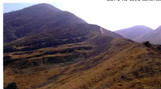
西门南侧城墙（滚落的城墙石）
