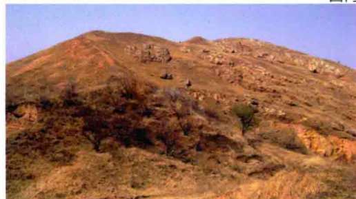
西门北侧城墙（山脊上）
