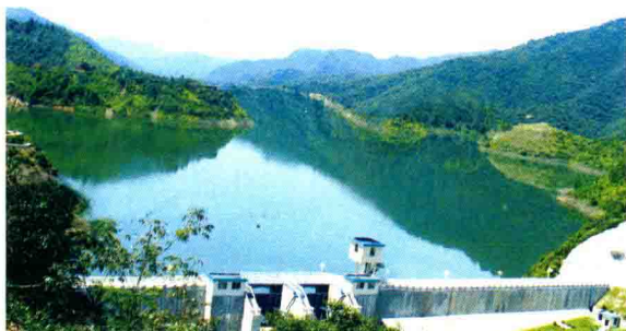
广东威华集团投资兴建的梅州市重点民心工程——清凉山水利枢纽工程（图为清凉山水库）
