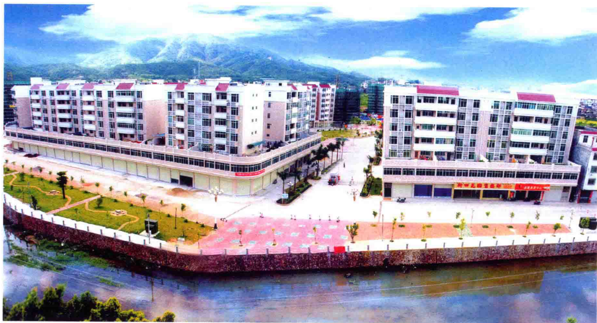
建设中的新田花园
