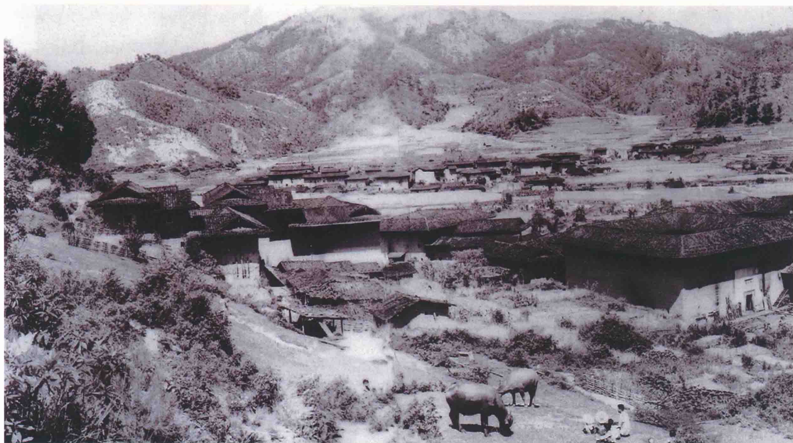
中央拨专款支持闽西老区重建家园——龙岩地区第一批重建的房屋（永定县歧岭乡）
