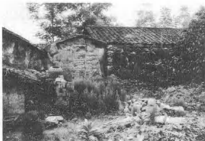
一九四九年五月中旬，被党方烧毁的 “潘三益油栈”留下的残壁一角。
