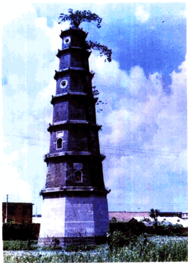
随州市区之文峰塔，重建于清光绪十年（公元1884年），塔高为25米，系砖石结构，气势雄伟。
