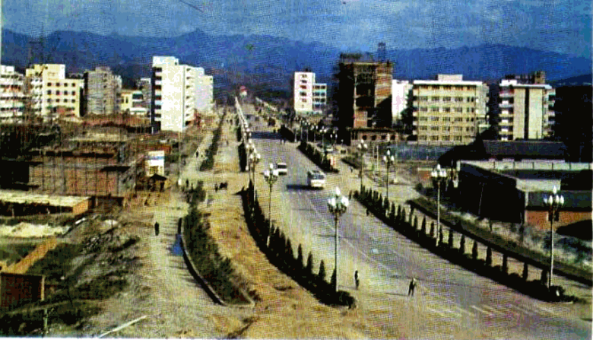
建设中的东坝新区
