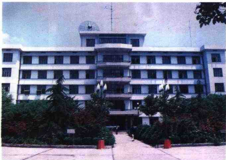
△浦口建筑工程公司承建的优良工程市委办公大楼(建国摄)
