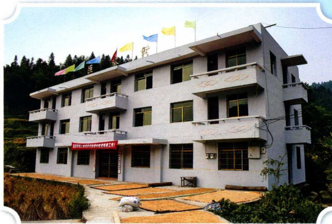
巨寨村办公楼 (黄大兴/摄)
