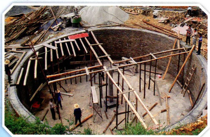
建设中的启蒙集镇供水厂 (党政办/提供)
