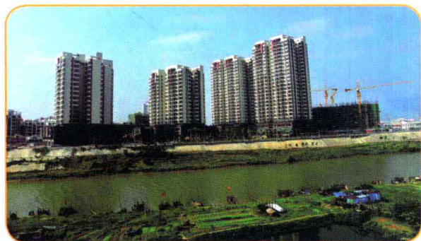
金沙咀国际广场二期商住楼
