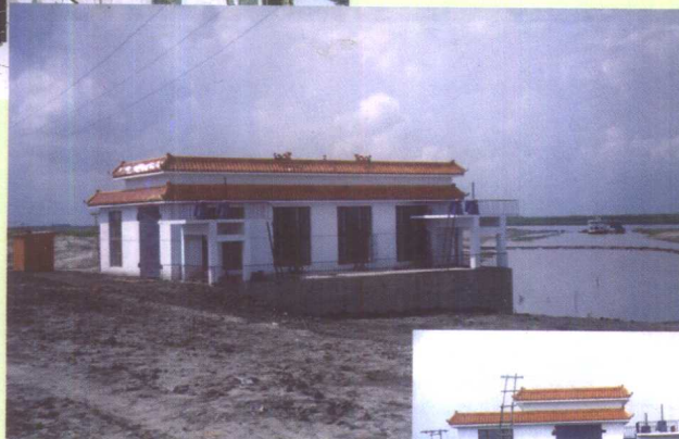
立陡山开发 小区出水池出水
