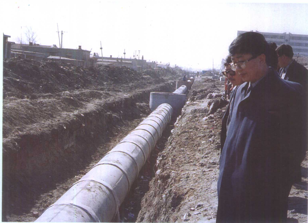
县领导视察地下排水工程
