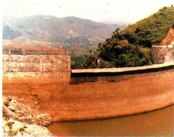
梅县松源高桥坑水库石拱坝
