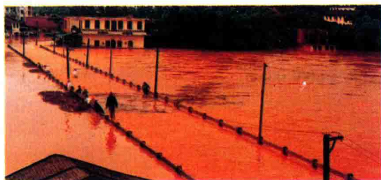
五华大坝公路桥受浸
