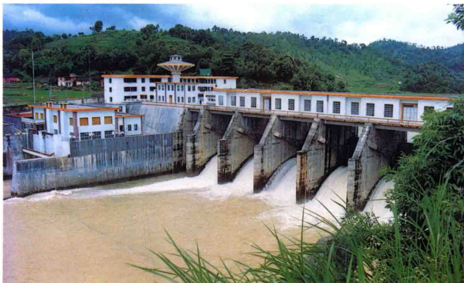
五华睦贤水电站
