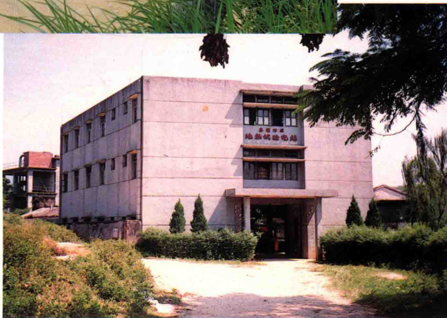
丰顺汤南邓屋地热电站
