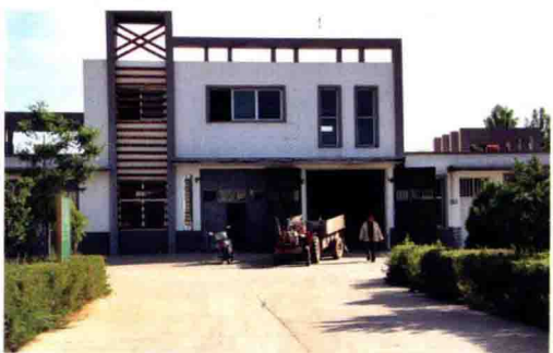
▲ 滨河社区垃圾压缩站
