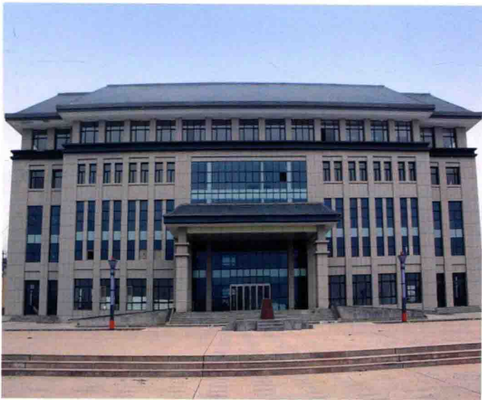
▲ 陈袁滩镇新建办公楼
