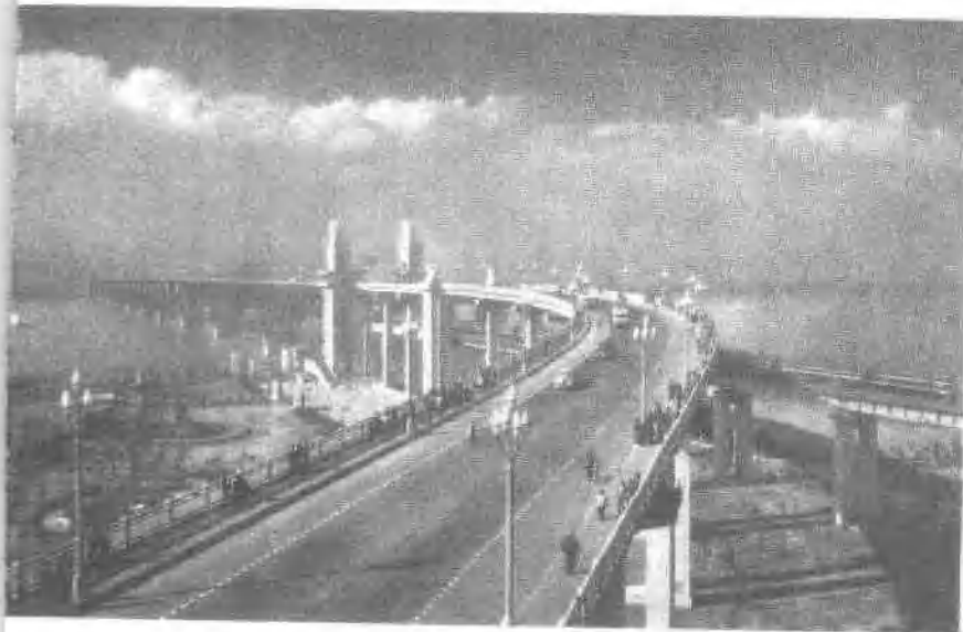
◀1968年12月29日，南京长江大桥建成。
