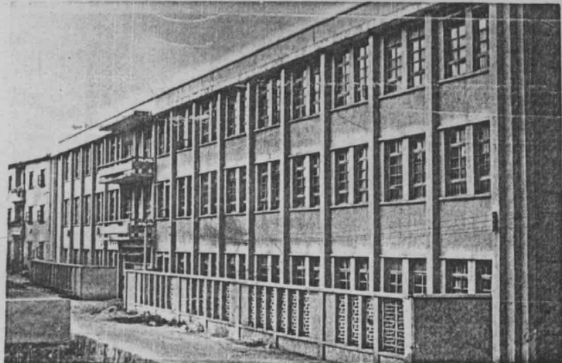
蕉岭县粮食局办公大楼
