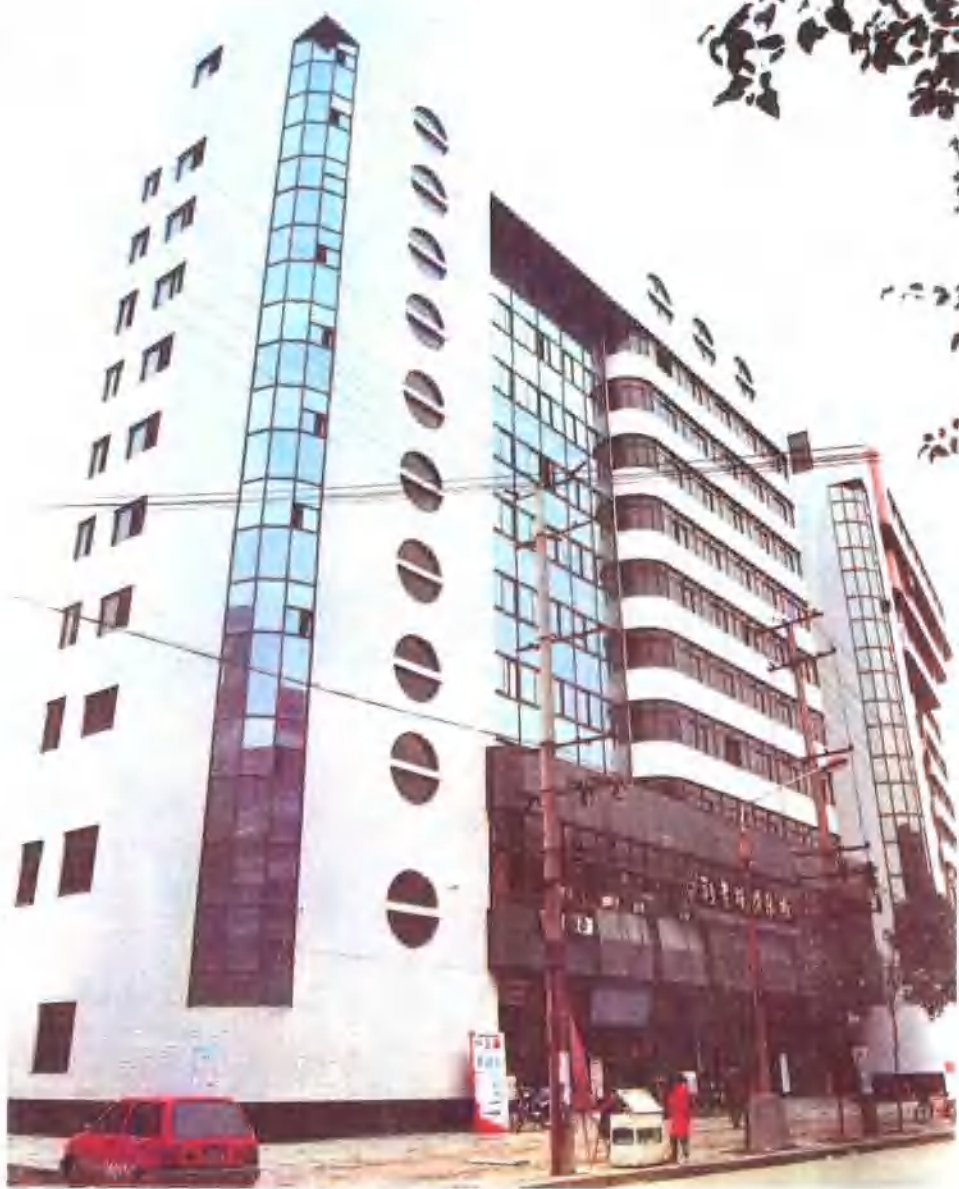
绵阳市工商局新建办公大楼
