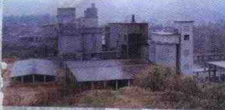
▲ 麻田镇水泥厂
